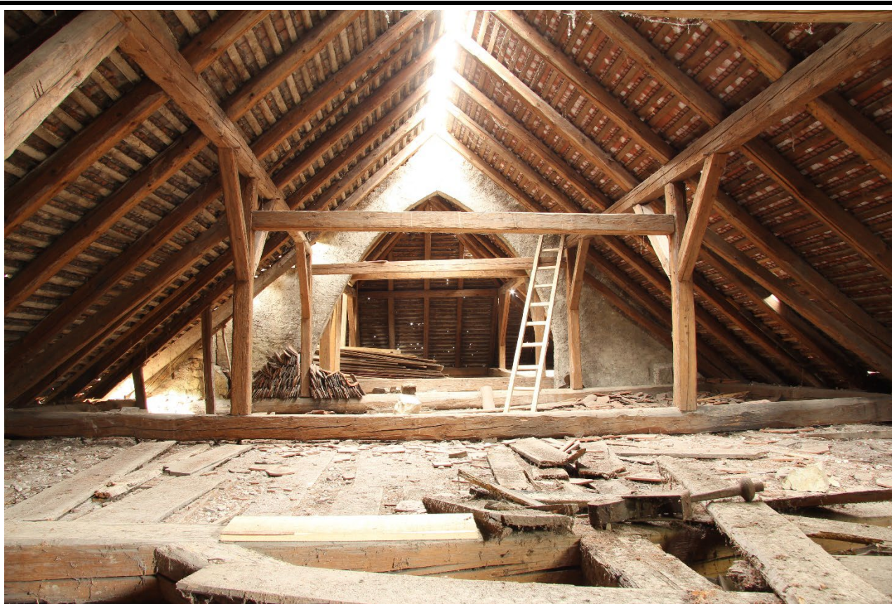
Pohled do krovu nad lodí směrem k východu. Foto: Jaroslav Skopec 2018.
