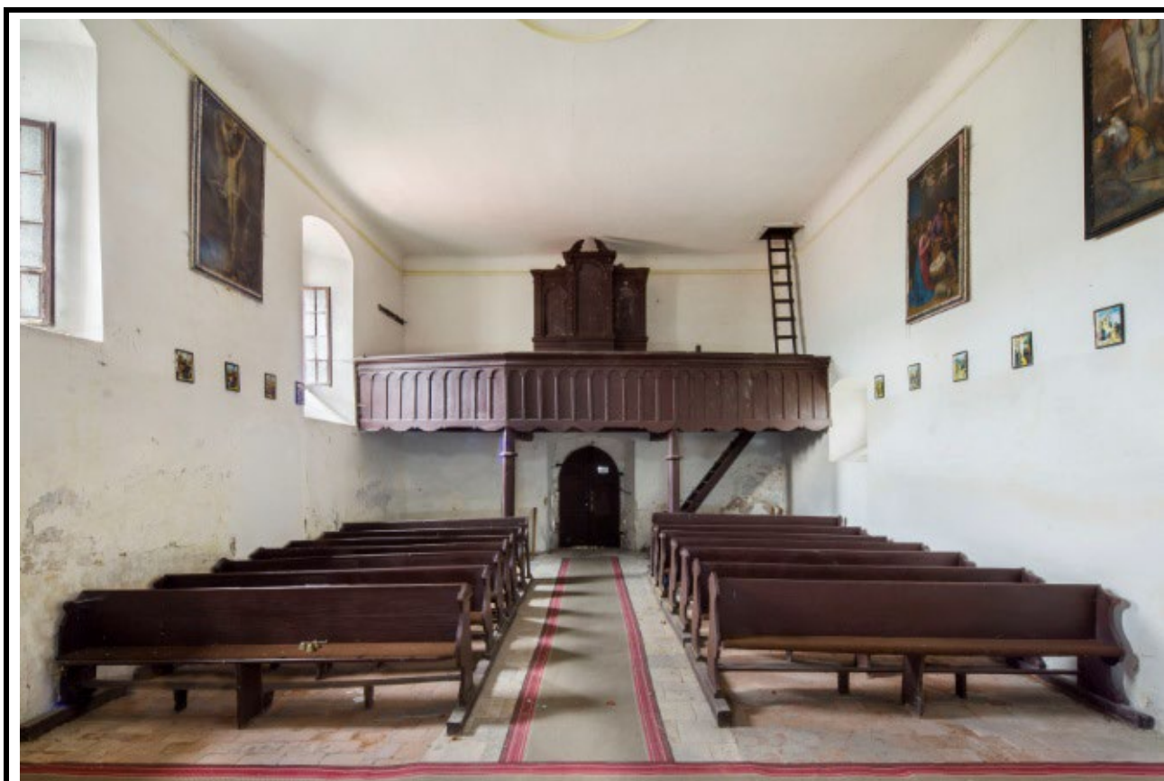
Interiér lodi v pohledu od východu. Foto: Marta Pavlíková 2018.
