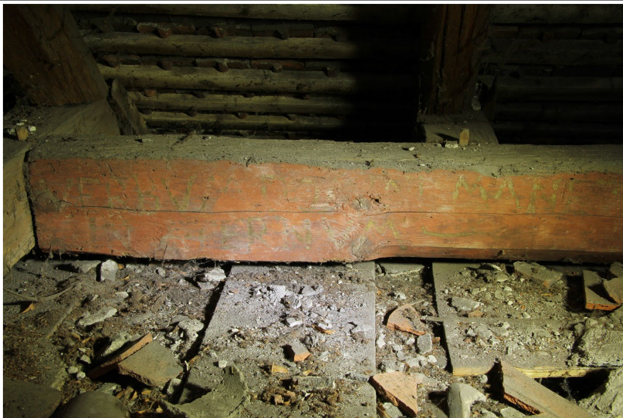
Detail severní výměny západní strany krovu nad lodí s latinským nápisem. Foto: Jaroslav Skopec 2018.
