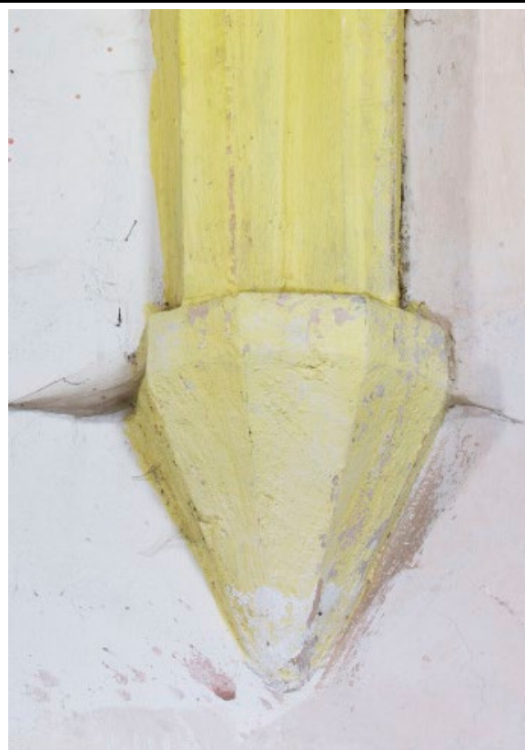
Detail druhé konzole od západu severní strany presbytáře. Foto: Marta Pavlíková 2018.
