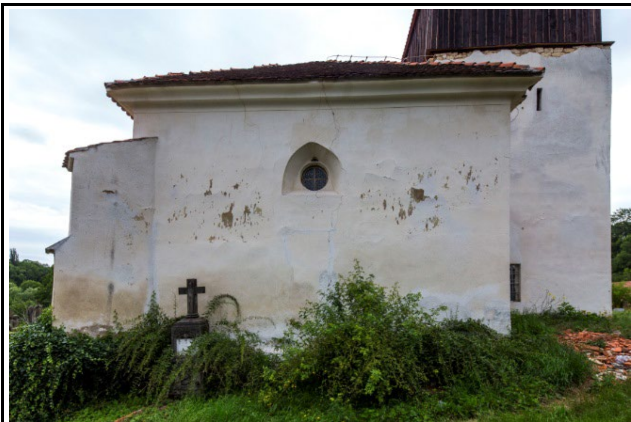
Východní průčelí presbytáře v pohledu od východu. Foto: Marta Pavlíková 2018.
