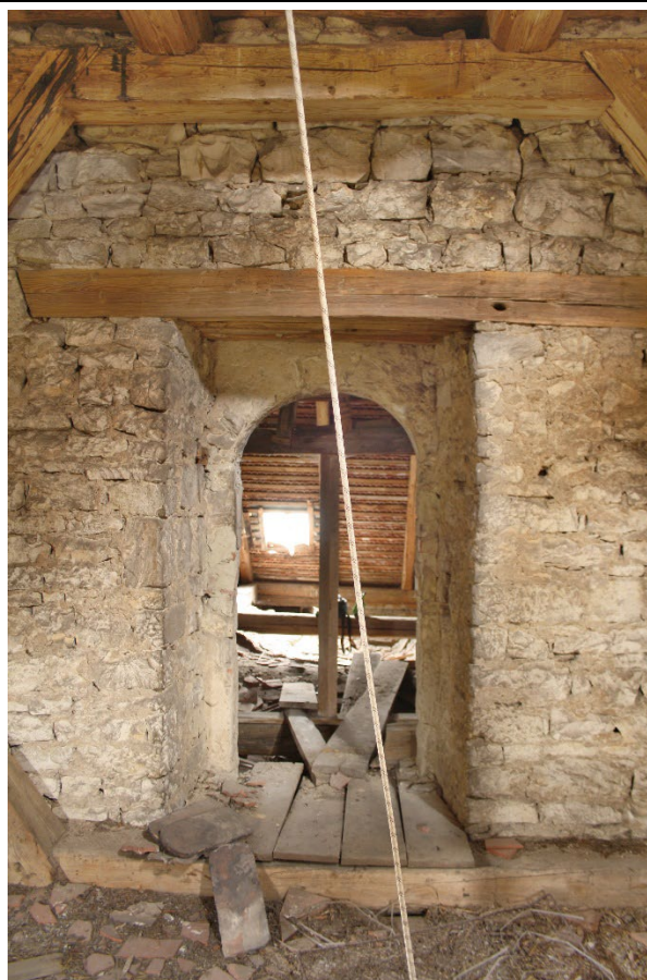
Vstupní otvor jižní stěny v 1. patře věže vedoucí do krovu nad presbytářem v pohledu od severu. Foto: Jaroslav Skopec 2015.
