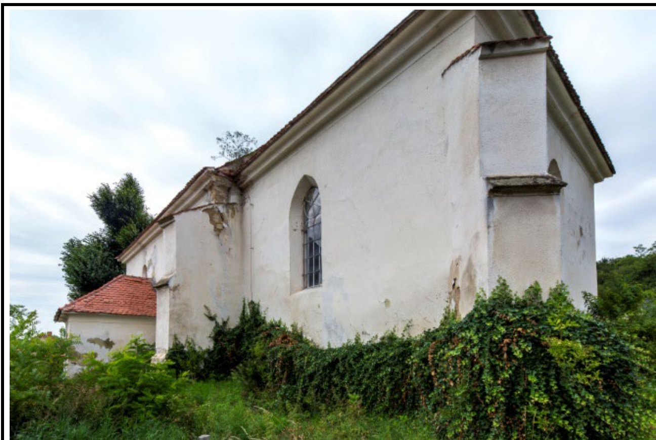
Celkový pohled od jihovýchodu. Foto: Marta Pavlíková 2018.
