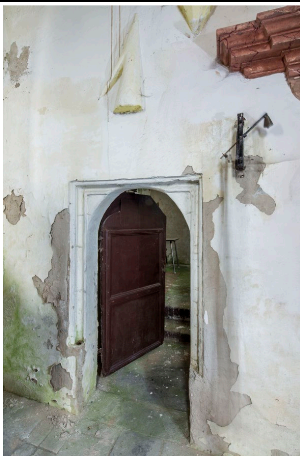
Portál do sakristie v severní stěně presbytáře v pohledu od jihovýchodu. Foto: Marta Pavlíková 2018.
