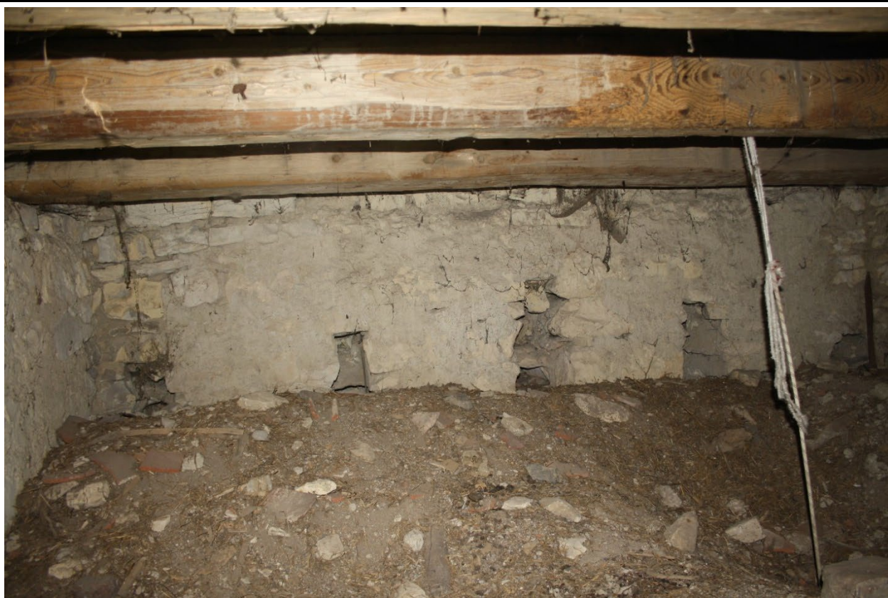
Jižní stěna prostotu pod podlahou prvního patra věže v pohledu od severu s kapsami po středověkém krovu. Foto: Jaroslav Skopec 2015.
