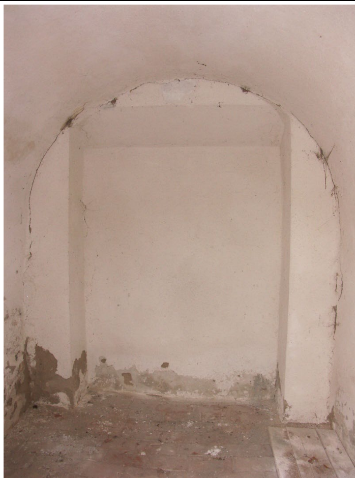
Pohled k severu do interiéru jižní předsíně. Foto: Jaroslav Skopec 2008.
