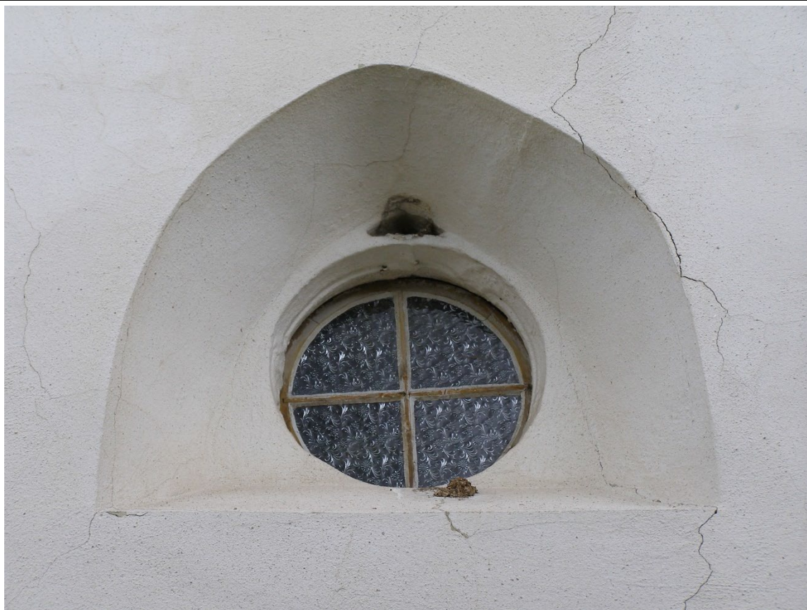
Detail okenního otvoru východního průčelí presbytáře. Foto: Jan Koloc 2008.
